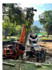
Excavación de pilotes.
