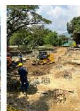
Nivelación y limpieza
