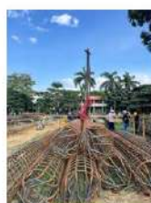
Armado de acero.
