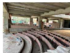
Muros para armado de losa auditorio
