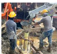
Fundición de pilotes.
