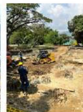
Nivelación y limpieza
