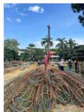
Armado de acero.
