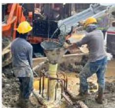
Fundición de pilotes.
