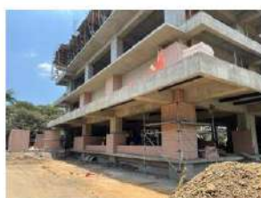
Muros en mampostería columnas pisos 1 y 2
