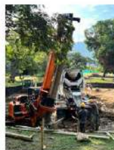
Excavación de pilotes.
