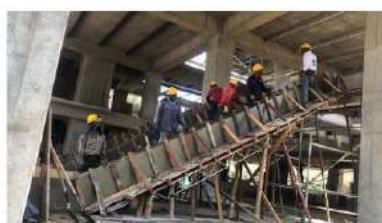
Armado de acero escalinata
